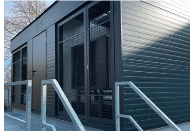
Fassade mit Profilblech
