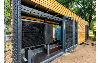
Fassade mit Holzverkleidung
