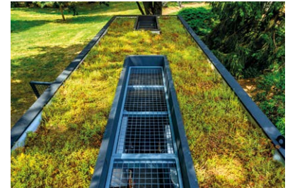
Beispielhafte Ausführung mit Dachbegrünung
